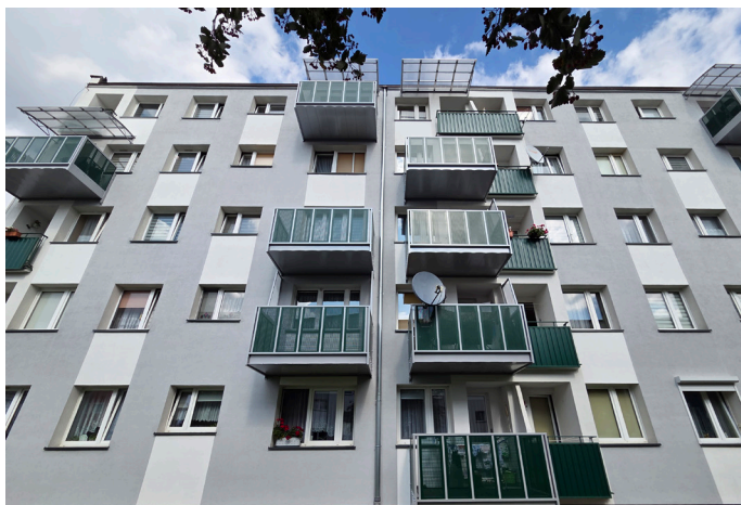
Budynek os. Kopernika 9 i Kopernika 23 z nowymi podwieszonymi balkonami
