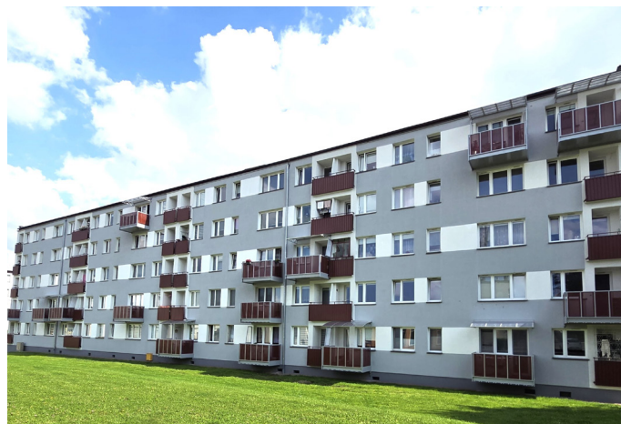
Budynek os. Kopernika 9 i Kopernika 23 z nowymi podwieszonymi balkonami
